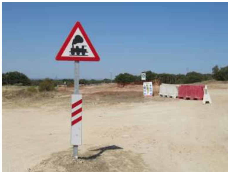
Comienzo de a obras en el extremo cercano a Toril
